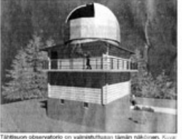
Tähtisuon observatorio on valmistuttu tähtitornin rakentamisen jälkeen. Kuva: Aikamääränsuunnittelija Aarne Hämäläinen.
